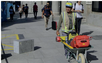
Un albañil trabaja en una obra del centro de Madrid. / OSCAR CHAMORRO
